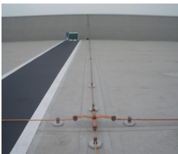
水平導体による 屋上部の保護例
