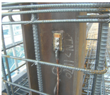
鉄骨利用例（柱鉄骨に溶接）
