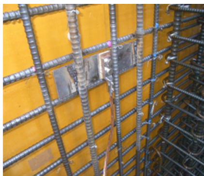
鉄筋利用例（柱鉄筋に溶接）
