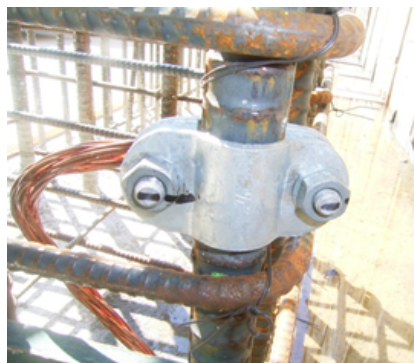
鉄筋利用例（柱鉄筋に接続）
